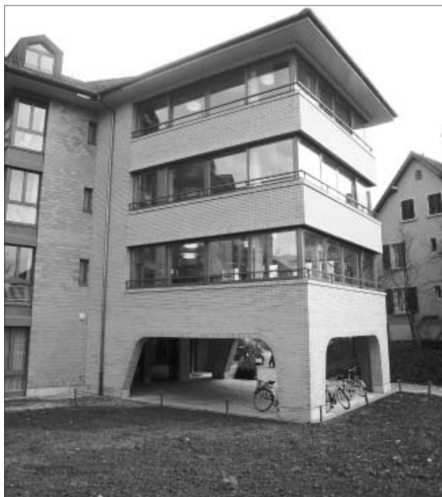
«Der Annexbau für die Wohnstuben-Erweiterung (Bild) ist quasi aus dem vorhandenen Bau herausmodelliert worden», erläuterte Lukas Zumsteg an der Einweihung, was mit «Integration in die bestehende bauliche Substanz» gemeint ist.
