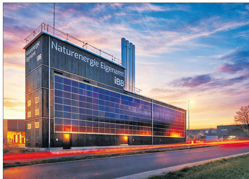
Das grosse Fernwärme-Engagement der IBB findet zum Beispiel bei der neuen Lupfiger Heizzentrale seinen auch architektonisch gelungenen Niederschlag. (Bild: Gion Pfander Fotografie, bearbeitet mit AI)
