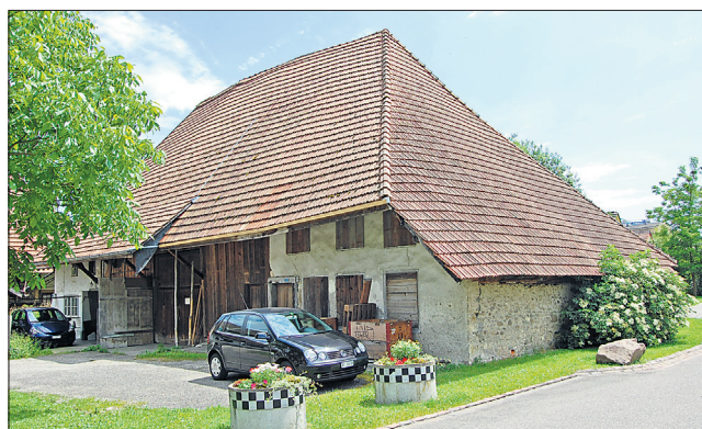
aus. Der Zustandsbericht ist unter www.hausenag.ch aufgeschaltet.
