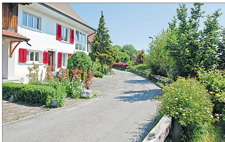
Oberdorfstrasse: Die teilweise vorhandene Abschränkung mit Schwellen wird bei der Sanierung durch Leitplanken ersetzt.
