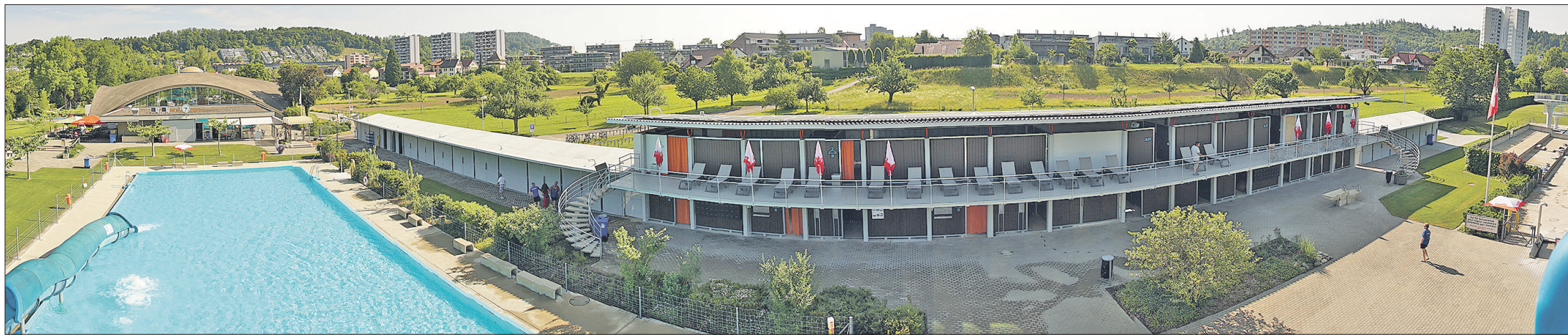
Die Panoramaansicht zeigt ganz links das Hallenbad, dann den Eingangsbereich, der mit Betonelementen neu erstellte Servicetrakt Nord, das komplett und aufwendig sanierte, zweistöckige Garderobengebäude des Architekten Walter Hunziker und der ebenfalls neue Serviceteil Süd. Am rechten Rand noch sichtbar die 2008 eingeweihten Springtürme der Architekten Froelich+Hsu.
