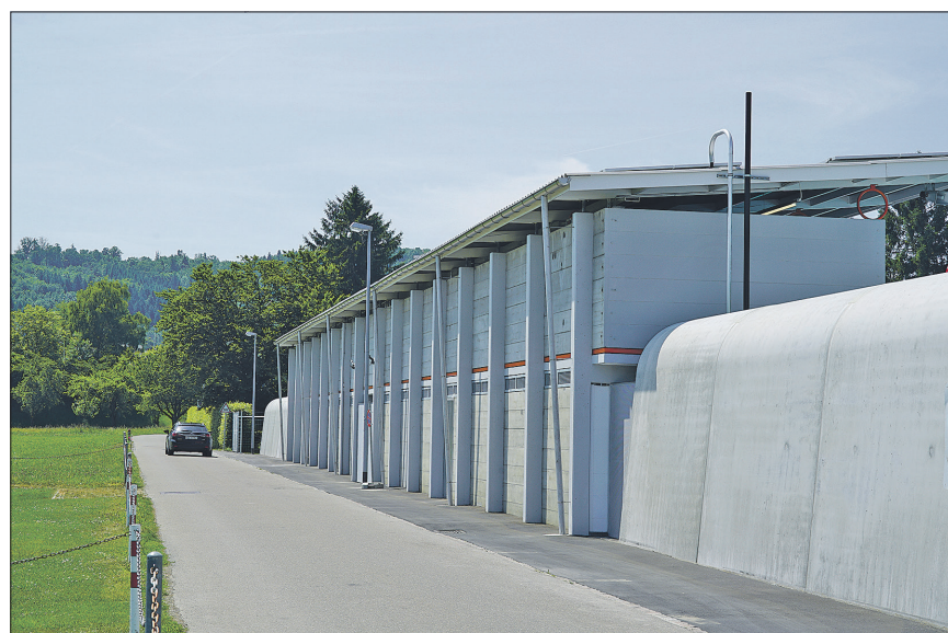
Die neuen Betonelemente im Vordergrund und die filigrane Struktur des Garderobengebäudes von der Kanalstrasse aus gesehen.
