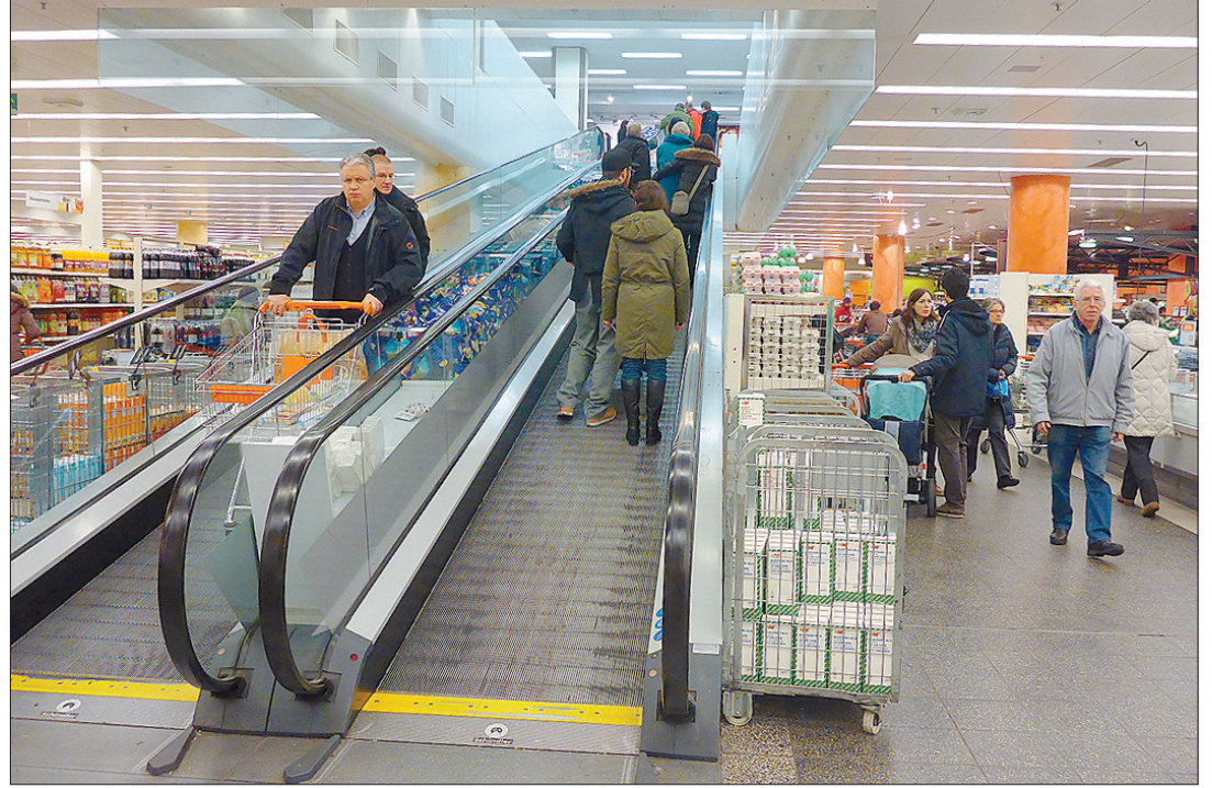
Das Rollband, die Verbindung vom Food- in den Nonfoodbereich, muss ersetzt werden.
