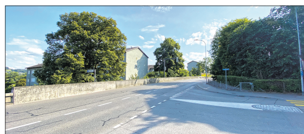
Jetzt wird hier gebaut – deswegen ist die Zurzacherstrasse bis Mitte August nur einspurig befahrbar.
