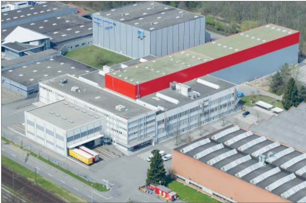
Seetal Elco im Wildschachen aus der Vogelschau: Das neue Hochregallager in markantem Rot ist 135 Meter lang, 22 Meter breit und 22 Meter hoch. In fünf Lagergassen haben 15'000 Paletten Platz.
