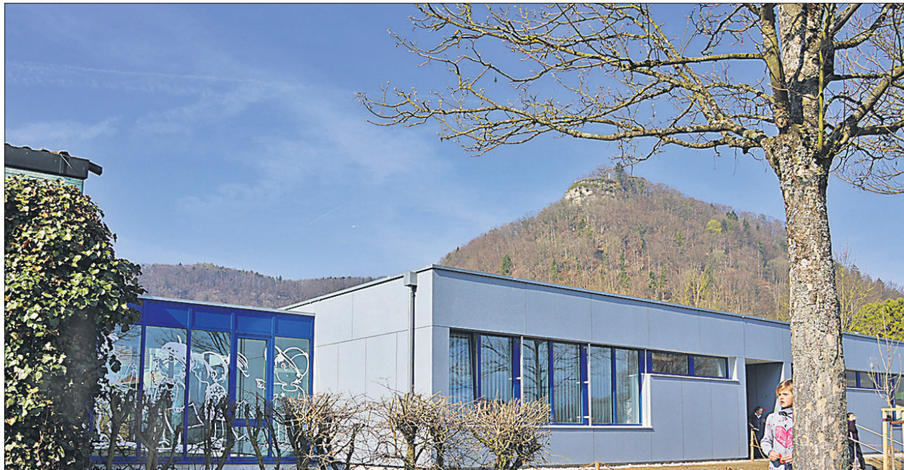
Seit dem 23. Februar gehen die Kinder von Villigen in den neuen, für 1,81 Mio. Fr. erstellten Kindergarten «Erslet». Quasi als Schutzpatron thront die Burg Besserstein über dem neuen Gebäude.
