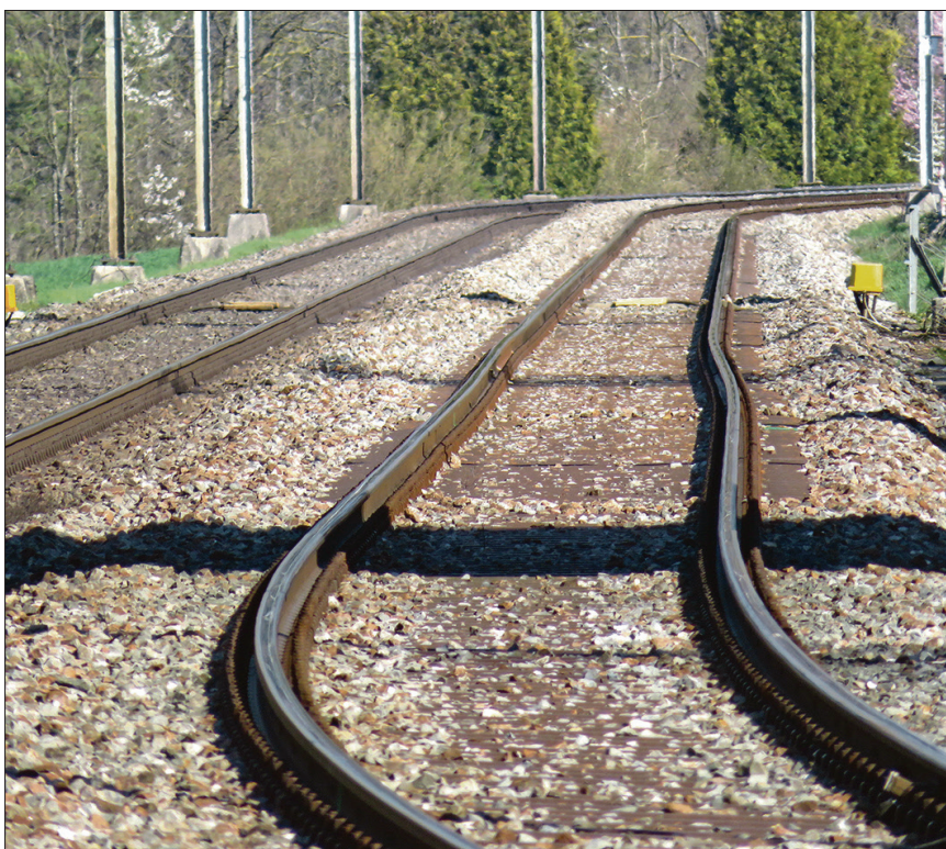
Blick auf die zu erneuernden Gleise
