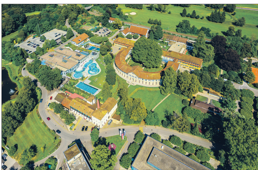
Aktueller Überblick über den Bäder-, Therapie- und Hotelteil der Gesamtanlage.
