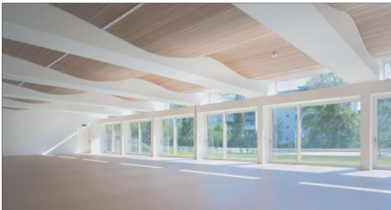
Im Sockelgeschoss befindet sich dieser grosse, stützenlose, unterteilbare Raum. Dafür wurde eine Abfangdecke mit vorgespannten Unterzügen und Betonstützen in den oberen Geschossen vorgesehen. «Wir geniessen diesen tollen Mehrzwecksaal, wo wir nun auch gemeinsam essen können», sagt Rolf von Moos.
