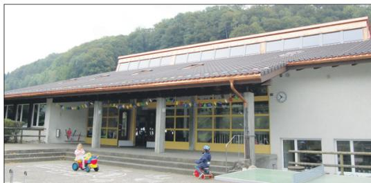
Dach renoviert, mit einer Isolation ergänzt sowie in jedem Schulzimmer zwei Dachfenster eingebaut. Eine Aussenisolation, eine neue Eingangsfront, neue Fenster sowie Auffrischungsarbeiten im Innern sind in der zweiten Etappe vorgesehen. Der Verpflichtungskredit von rund 400'000 Franken wird der bevorstehenden Wintermeind vorgelegt. Die Ausführung ist in den Sommerferien 2015 geplant. Danach wird das Gebäude energetisch gesamtsaniert sein.
