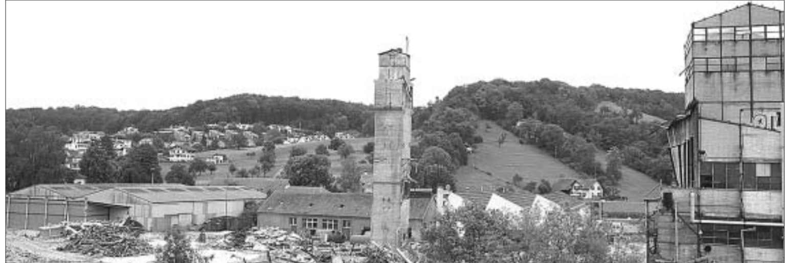
Vom Autobahnzubringer hat man jetzt freien Blick Richtung Eitenberg. Von dort stammt die Aufnahme unten – da stand das nunmehr abgeprozte Gebäude noch (Pfeil).
