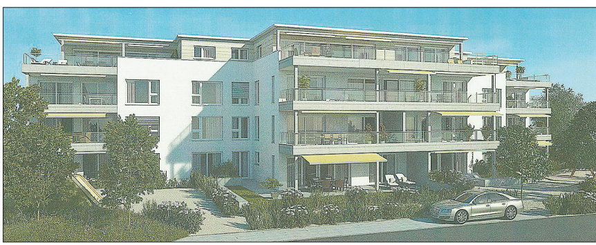
Die «Wohnseite» des «Piccadilly» in Hausen: aufgelockerte Fassaden und viel Grün tragen zur attraktiven Wohnraumgestaltung bei.
