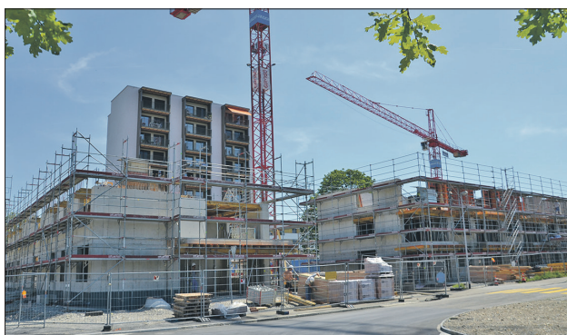
Die Seniorenwohnungen der Schönegg Brugg AG auf dem Areal des ehemaligen Alterszentrums wachsen planmässig empor.
