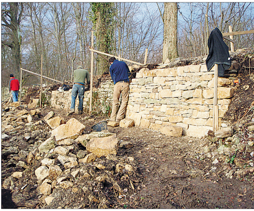
Nützliches Steinband: An der Sonnhalde sind die Arbeiten an der Waldrandmauer schon weit fortgeschritten.
