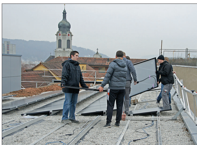
Lehrlinge tragen die Solarpanels auf dem Dach zum Installationsort.
