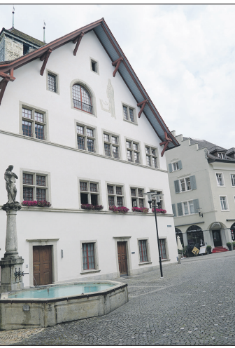
Das Rathaus ist zwar instandgehalten, weist aber nach Stratus trotzdem Defizite aus. Dahinter der geschichts- und renovations-trächtige Schwarze Turm.
