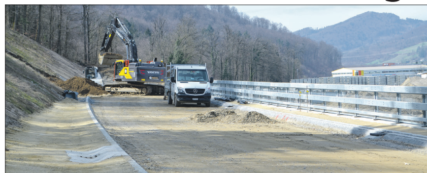
Die neue Verbindungsstrasse oberhalb der Firma Creabeton.
