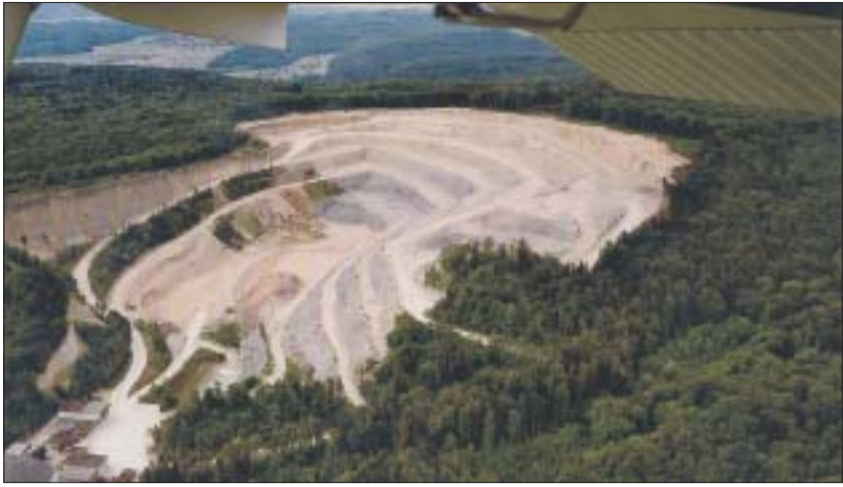
Blick aus der Vogelschau auf das «Gabenkopf»-Abbaugelände.
