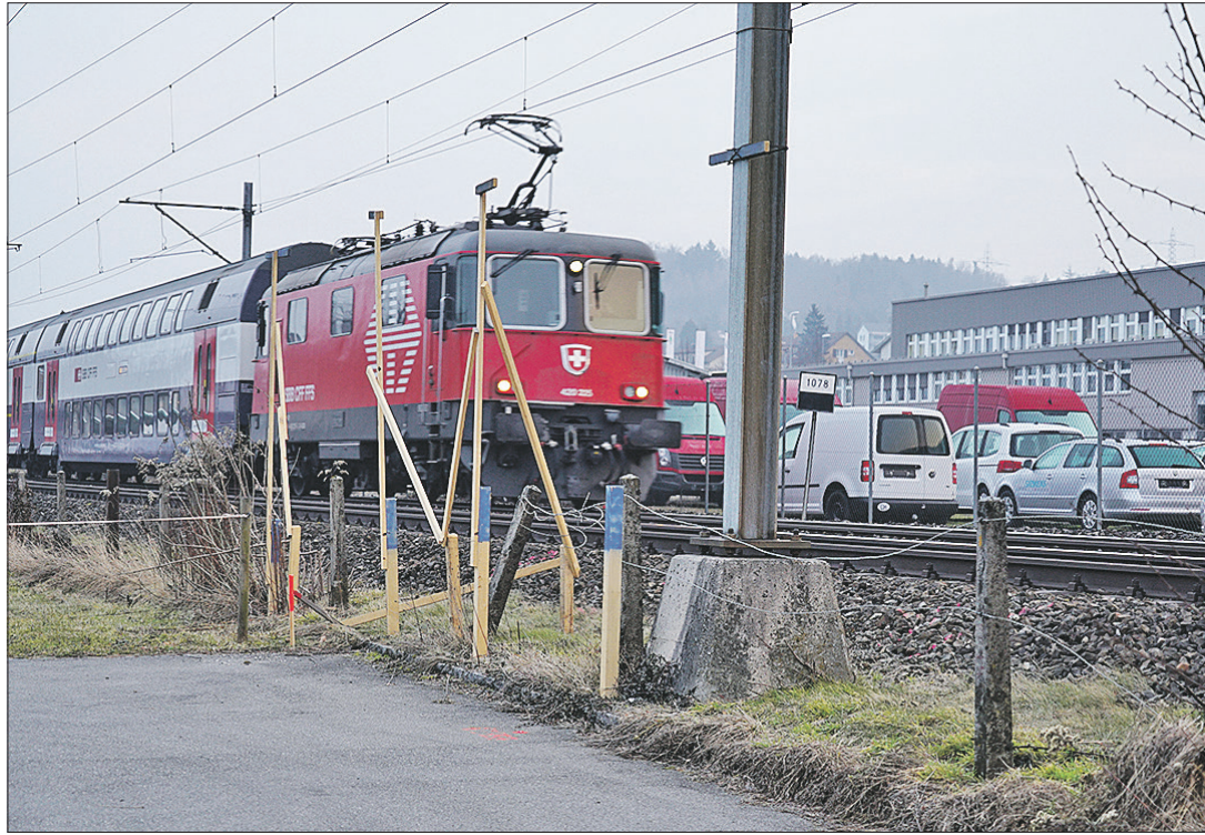
Lärmschutzwand-Bauprofil an der Ölermattstrasse in Schinznach-Bad.
