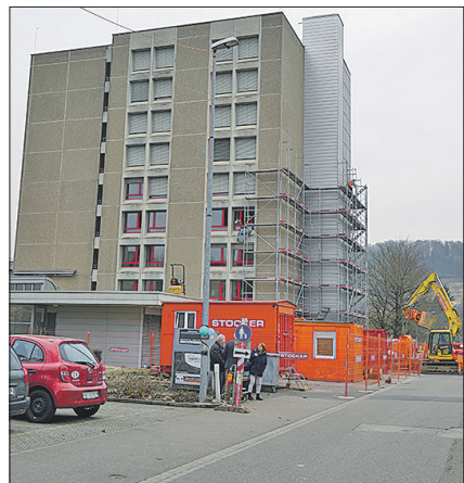
Rückbau bis aufs statische Skelett.
