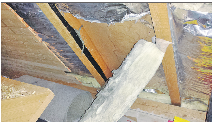
Dachschaden am Schulhaus Habsburg: Die beschädigte Isolation - hier sichtbar im Materiallager – soll erneuert werden.
