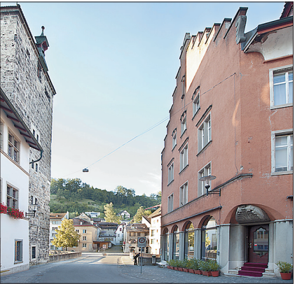
Markant, geschichts- und problemträchtig: Die erste Genossenschaftsliegenschaft der GAB.
