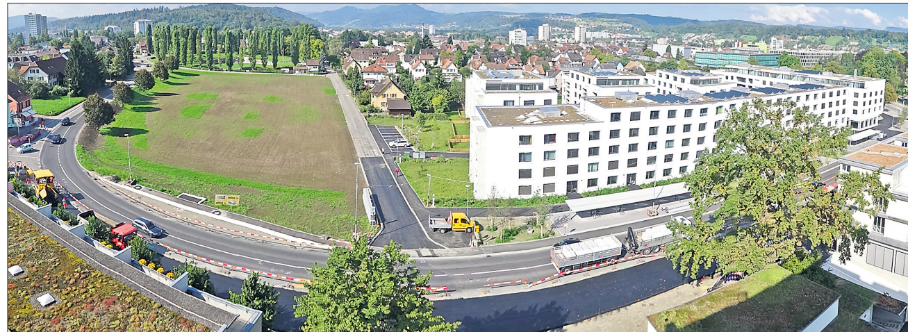
Umgestaltung Hauserstrasse: Von den Gesamtkosten (inklusive Erneuerung Werkleitungen, lärmoptimiertem Belag und Bepflanzung) von 1,7 Mio. Franken für den 250 Meter-Abschnitt gehen 44% zu Lasten von Windisch.
