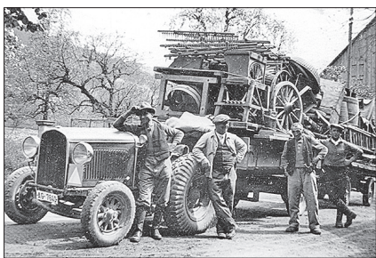
Ruedi Amslers Grossvater Samuel Amsler 1920 mit seinem ersten Traktor, den er aus einem 8 Zylinder-Chrysler-Motor und einer Bühler-Vorderachse selber baute.
