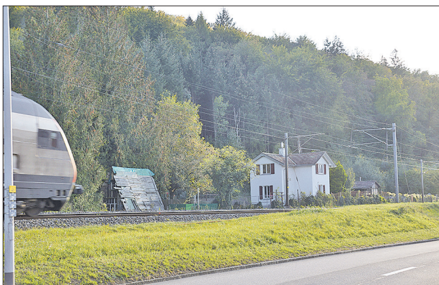
Das sich in einfachstem Zustand befindliche Haus an der Aarauerstrasse liesse sich wieder mieten – oder auch kaufen.
