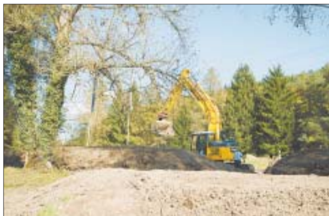
Ein neues Tee, ein neues Green und ein grosser Bagger für die Geländeformung geben einen Eindruck von den Dimensionen der Arbeiten.
