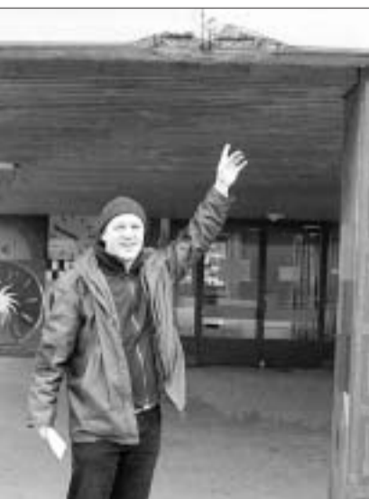
Bauverwalter Kurt Schneider macht auf die Schäden an der Aussenfassade aufmerksam.
