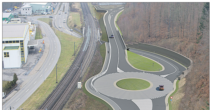
In Zukunft gehts eingangs Brugg vom Kreisel West über die neue, parallel zur Bahnbrücke verlaufende Strassenbrücke zur Autobahn.
