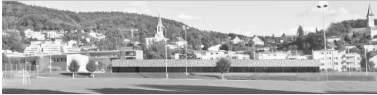
Durchdachtes Konzept: Die Dreifachhalle schliesst an die östlich gelegene alte Turnhalle Brühl an, welche voll integriert wird und Schul- und Vereinszwecken dienen soll.
