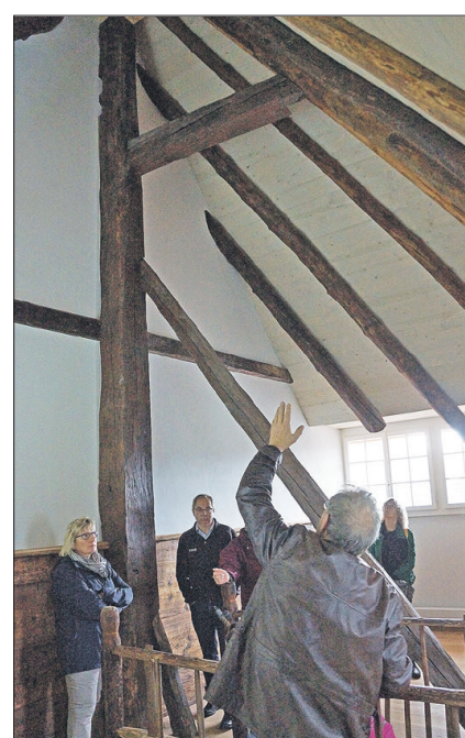
Robert Kühnis betonte auf der Führung unter anderem, dass in vier der fünf Wohnungen die abgebauten und neu gesetzten Balken gezeigt würden – wobei ein 40 Zentimeter starkes neues Dach quasi auf das alte gesetzt worden sei.
