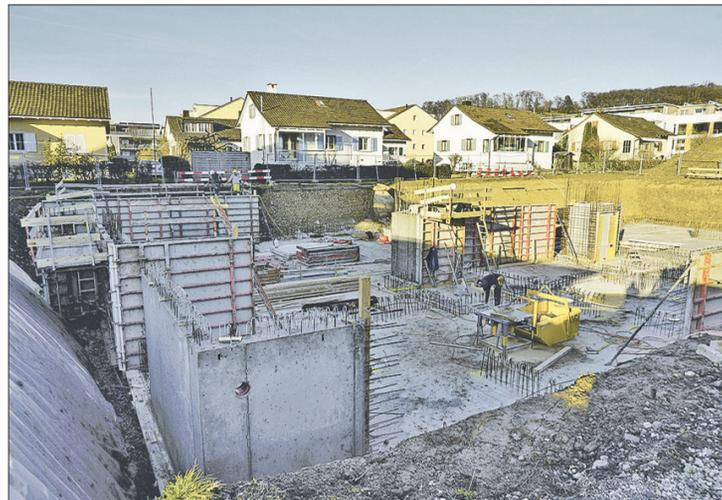
Links die Quadro-Überbauung – der Blick ins Grüne ist gewährleistet. Rechts der aktuelle Stand der Dinge: Die Grundplatte ist bereits gegossen, nun werden die Aufbauten gemacht, bis die Erdgeschoss-Erstellung erfolgt.
