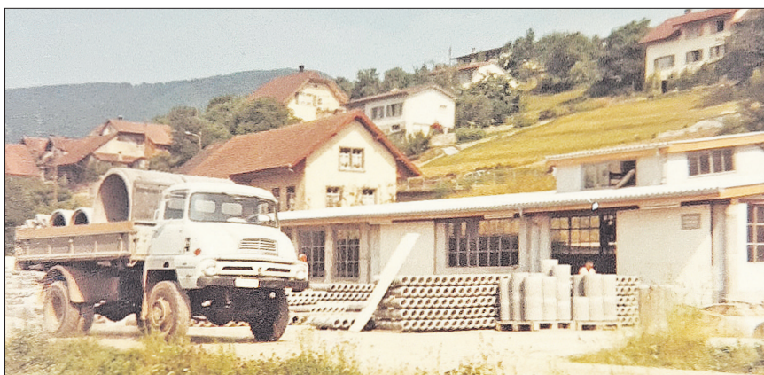
Ein Bild aus den Glanzzeiten der 70er-Jahre, als das Unternehmen Betonröhren sonder Zahl für die Kanalisationen produzierte. Seine grosse Stärke liegt noch heute – oder vielmehr bis Ende Jahr – in der Herstellung von massgeschneiderten Zementwaren.
