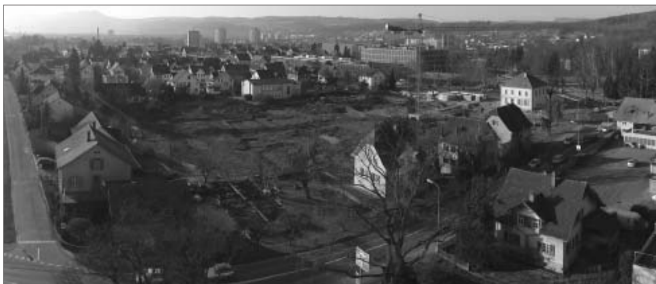
Blick vom Gemeindehaus aufs Areal, dessen Tage als Zentrumsbrache gezählt sind (rechts der Kreisel Harmonie).
