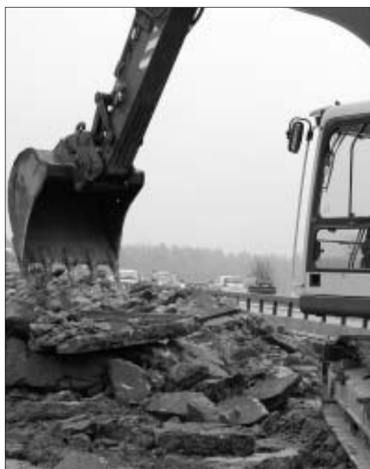
Die Betonpiste wird mit dem Bagger buchstäblich aus den Fugen gehoben.
