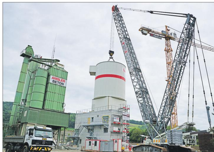
Präzisionsarbeit: Millimetergenau platzierte Kranführer Meinrad Riebli den zylindrischen Siloturm auf das Betriebsgebäude.
