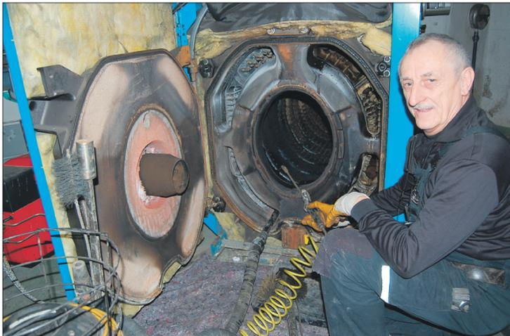
«Ich war immer gern Kaminfeger»: Hermann Gysel bei der alkalischen Reinigung des Brennraumes einer modernen Heizungsanlage in Remigen.
