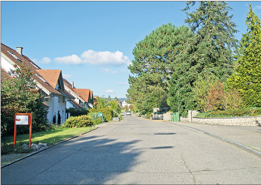
45 % der Investitionsmittel betreffen im Jahr 2015 Gemeindestrassen-Sanierungen – Haupt-Ausgabeposten ist die Jurastrasse (Bild).
