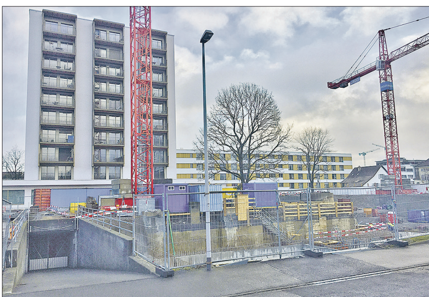
Im Bild der Eingang zur Zivilschutzanlage – es veranschaulicht auch, dass bei der geplanten Sanierung die Koordination mit der Baustelle der Seniorenwohnungen eine Herausforderung darstellen wird.
