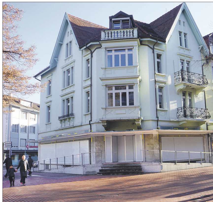
Blick auf das Eckgebäude, wo die Rampen verschwinden sollen.
