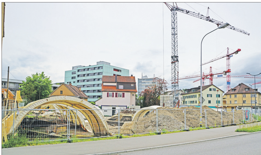
Blick auf die Sanavita-Baustelle, wo gegenwärtig die Kantonsarchäologie mit Abklärungen befasst ist, bevor die Arbeiten weitergeführt werden können.
