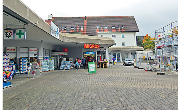
Der Migros-Markt in Lupfig wird vergrössert und modernisiert. In der hinteren Bildmitte der ehemalige Spar-Eingang, wo neu Büros und Personalräume untergebracht werden. Rechts der im Bau befindliche Bistro-Pavillon.
