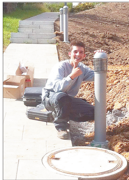
Ausbildung im Fokus: Erstjahr-Lehrling Simon Staudacher montiert hier eine Gartenbeleuchtung.
