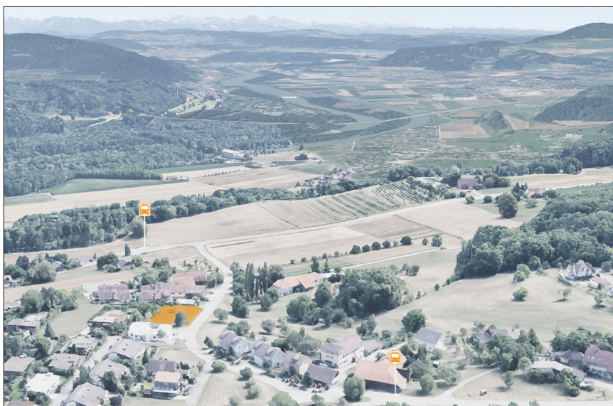
Das Bild zeigt den Bauplatz an auch verkehrstechnisch bestens erschlossener Lage: Ob mit Bus, Auto oder Velo, flugs ist man im Zentrum von Brugg – und wieder zurück im schönen Zuhause.
