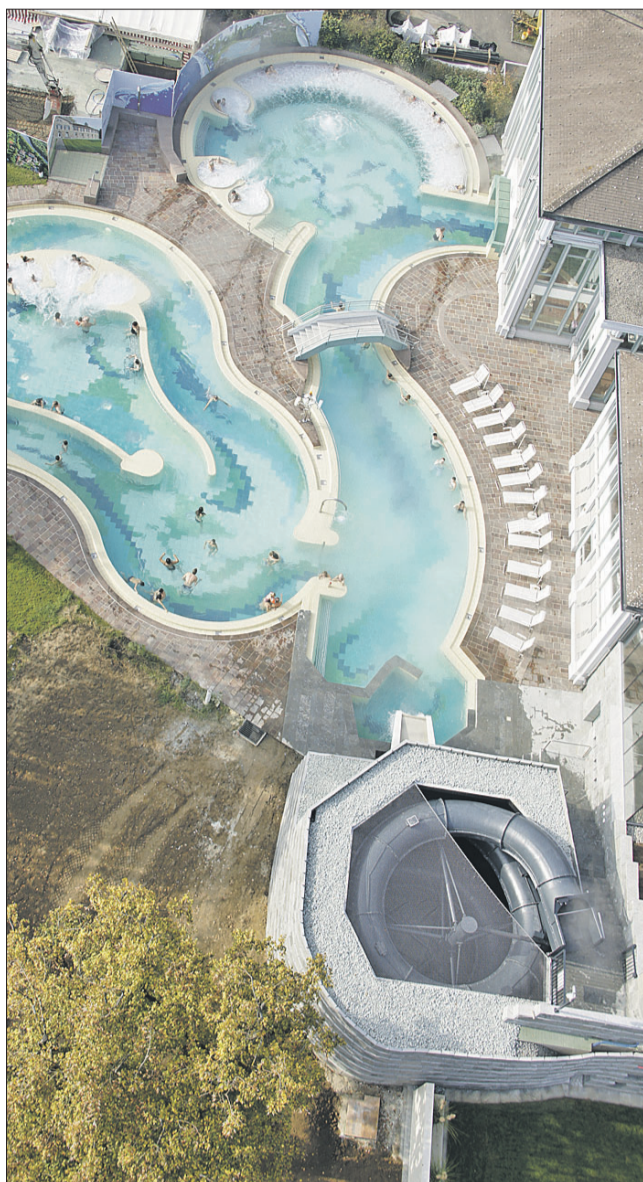
Das Aquarena-Angebot wurde ebenfalls ausgebaut: Die neue, 65 Meter lange und 8 Meter Gefälle aufweisende «Grottenrutsche» (im Bild rechts unten) ist ein echter Spassbringer.
