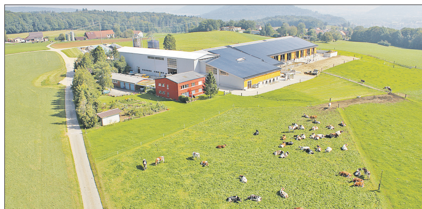
Der Grundhof aus der Vogelschau. Links in rot die extra abseits positionierte Trafostation, wo der Gleichstrom in Wechselstrom umgewandelt und ins Netz gespiessen wird, ohne dass Magnetfelder die Tiere beeinträchtigen.
