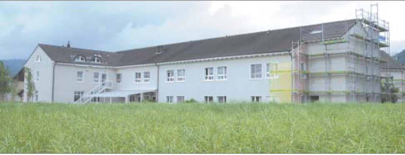
Alters- und Pflegeheim Schenkenbergertal im neuen Kleid – und mit dem Anbau, der, samt weiteren Sanierungen des Heims, 1,6 Mio. Franken gekostet hat.
