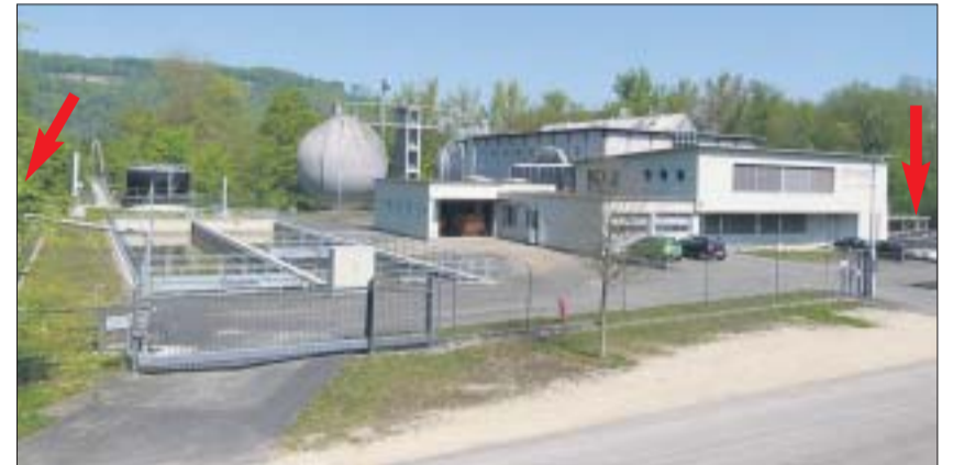
Der rechte rote Pfeil zeigt die heutige biologische Reinigungsstufe, die nach dem Bau des neuen «Festbett-Bioreinigungs-Gebäudes» (linker Pfeil) zurückgebaut und renaturiert wird.
