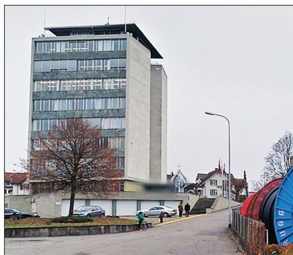
Provisorische Schutzmassnahmen: Das elegante Kabelwerk-Verwaltungsgebäude soll verkleidet werden.
