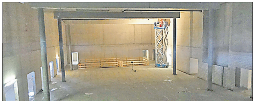
Der Hauptteil der Brugger Investitionen entfiel 2011 auf den Stadtsaal (Bild) – dafür hatte die Stadt Brugg der Campussaal Immobilien AG 7 Mio. Franken zu entrichten. Mehr zum «Rohbauende-Fest» vom 2. Juni, an dem der Saal der Bevölkerung gezeigt wird, in einer der nächsten Ausgaben.
