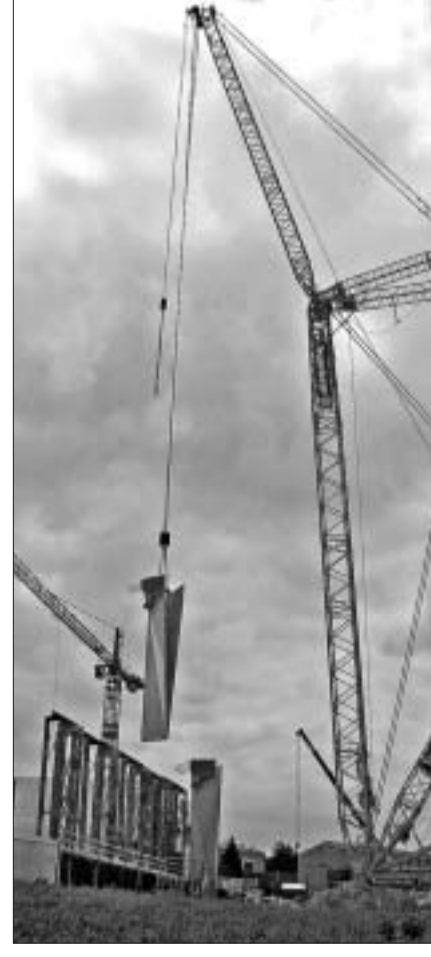
Spektakuläre Bauphase im Juni '09, als ein 500-Tonnen-Raupenkran – der grösste der Schweiz – die bis fast 50 Tonnen schweren Betonelemente an ihren Platz manovierte.
