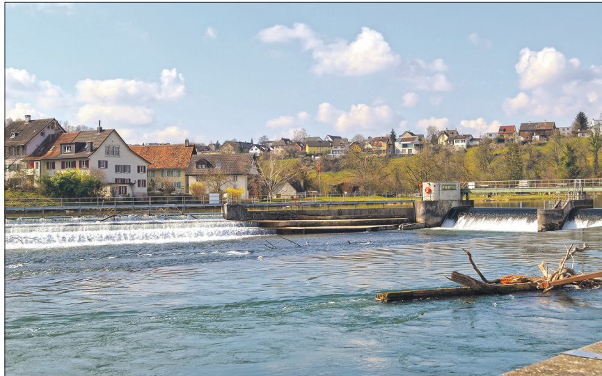
Beim Kleinwasserkraftwerk in Windisch wird Kies dazugeschüttet, um die Geschiebedurchgängigkeit zu überprüfen.
