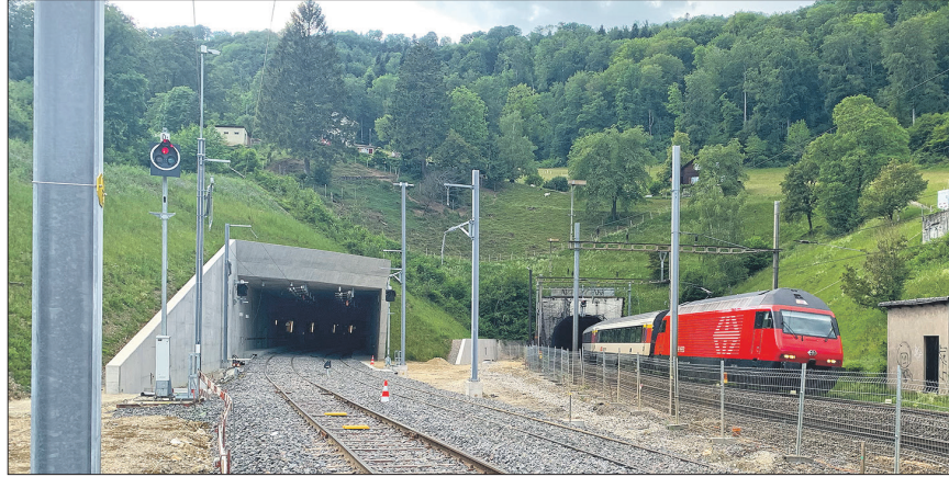
Bözberg-Tunnel: Am 9. März 2016 war Spatenstich – und nun ist es dann bereits realisiert, das mit 350 Mio. Franken grösste Einzelprojekt des 4-Meter-Korridors, dank dem auch grosse Sattelaufleger auf der Gotthard-Achse mit der Bahn transportiert werden können.
