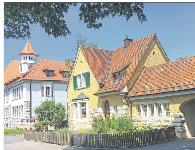
Das Abwartshaus, auch «Stapferhüsli» genannt, steht unter kantonalem Denkmalschutz und bildet in der Sichtachse der Museumstrasse ein wichtiges städtebauliches Element. Das kostet.
